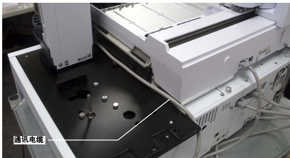
图 21 沿着样品盘安装支架布置前进样塔电缆。
