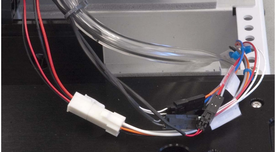
Figura 53 Collegamento dei cavi
