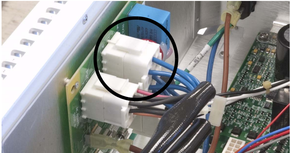
Figure 2 Installation de la prise de configuration
