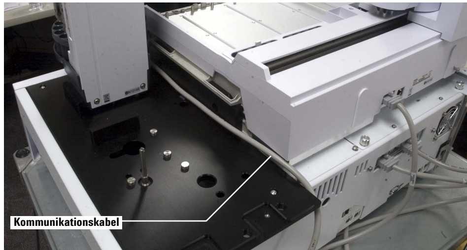
Abb. 21 Verlegen des Übertragungskabels des vorderen Turms entlang der Halteklammer des Probenellers.
