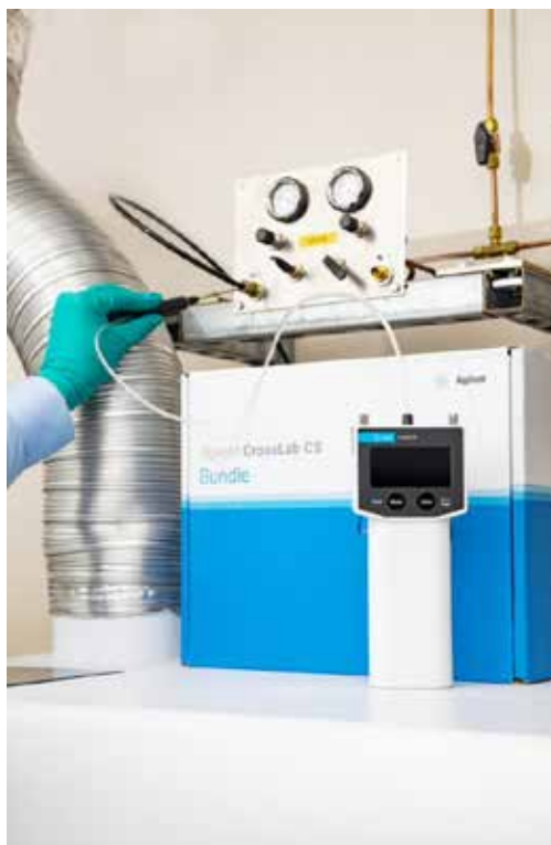
Figura 10. Ejemplo de la comprobación de los conectores de tubos de gas argón con el detector de fugas electrónico Agilent CrossLab CS.
