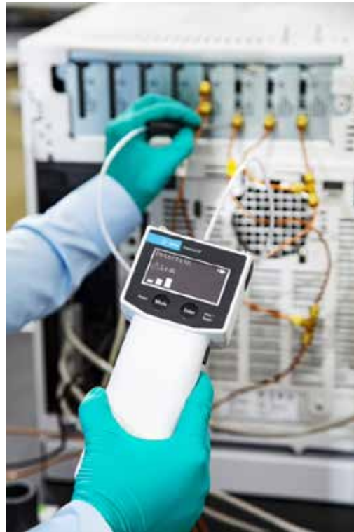
Abbildung 9: Beispiel für eine Dichtigkeitsprüfung von Gasfittings auf der Rückseite eines Agilent 8890 GC-Systems.
