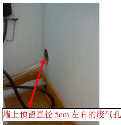
图二：墙上预留直径5厘米左右的废气孔
