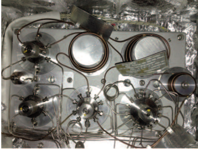
图 2. 已安装色谱柱且拆盖的大阀箱。所示为色谱柱 1、2 和 3
